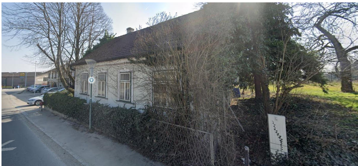
Abbildung 25: Ansicht auf das Bestandsgebäude im künftigen BA an der St. Pöltner Straße (Quelle: Google Street View).
