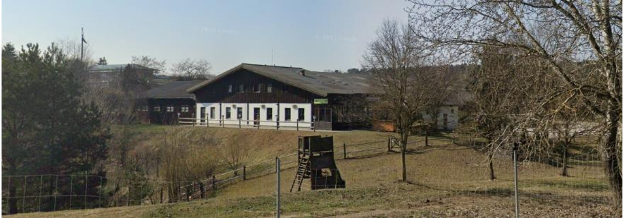
Abbildung 20: Ansicht auf die bestehende Reithalle im Bauland-Sondergebiet, südlich der Umwidmungsfläche (Blickrichtung Südwesten, Quelle: Google Streetview)
