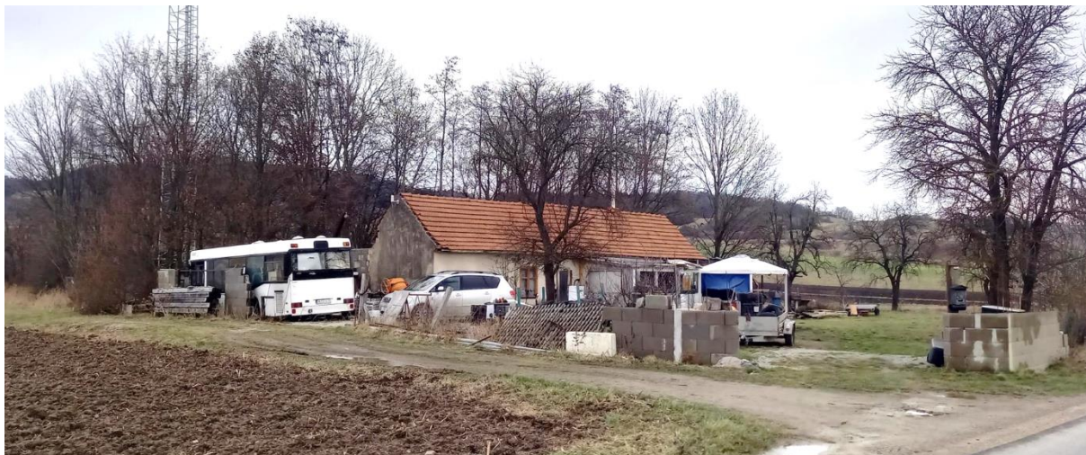
Abbildung 14: Ansicht auf das derzeitige Geb17 in Blickrichtung Nordosten.
