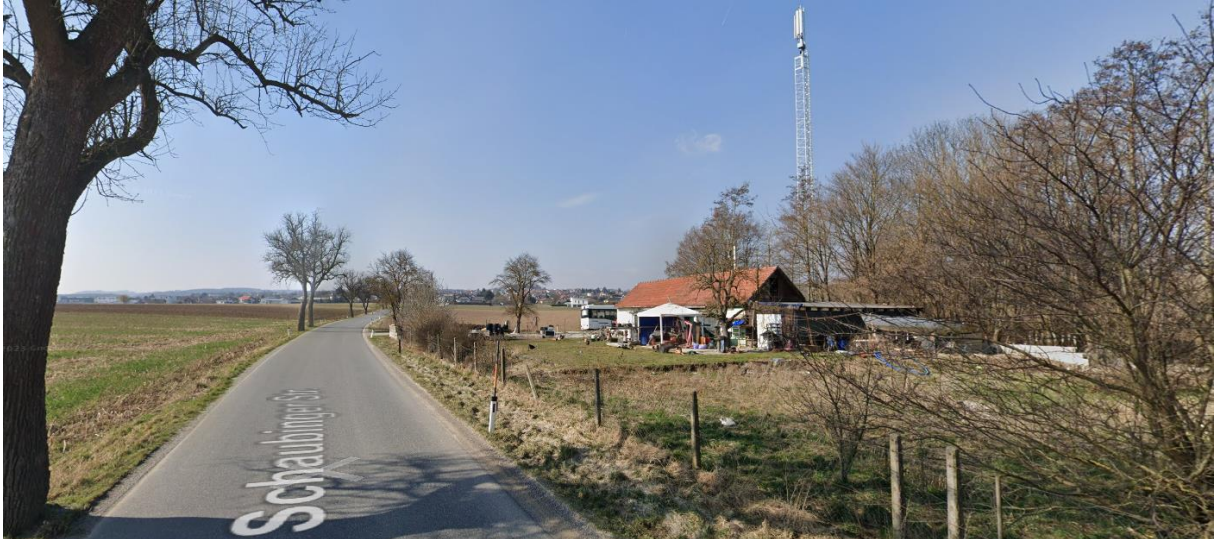
Abbildung 15: Ansicht auf derzeitige Geb17 in Blickrichtung Hauptort Karlstetten im Westen (Quelle: Google Street View).
